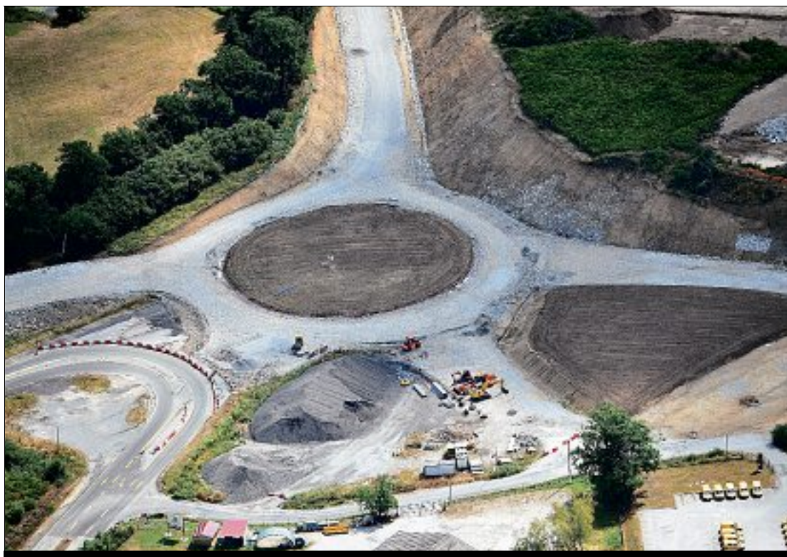
CHANTIERS. Les chantiers de la déviation de La Gratade, à Croze et du carrefour de la Seiglière, à Aubusson (photo), sont pointés du doigt par les associations environnementales. FLORIS BRESSY AVEC LE CONCOURS DE L'AÉROCLUB DE LA CREUSE
