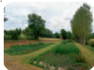
La récente station d'épuration à bassins végétalisés de Bussière Poitevine
