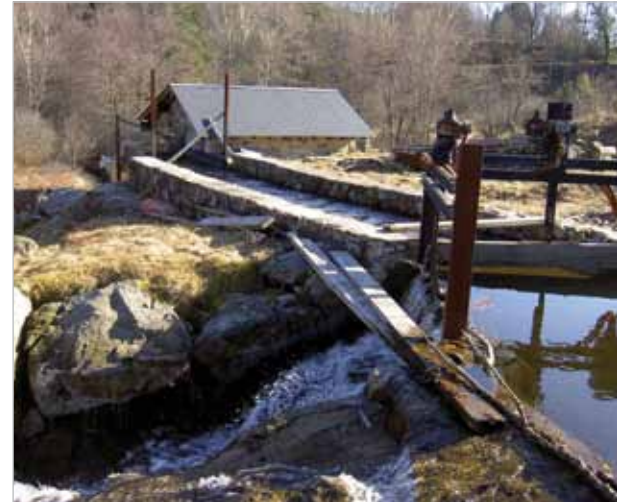
Travaux d'aménagement d'un moulin en corréze (photo SRL)
