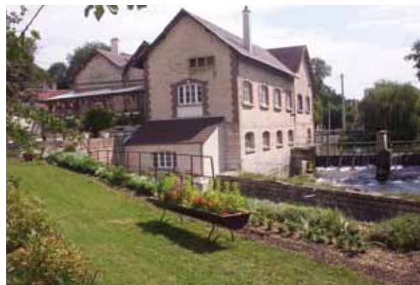
Micro-centrale hydroélectrique de Chappes (AUBE) - Paul Vinot.
