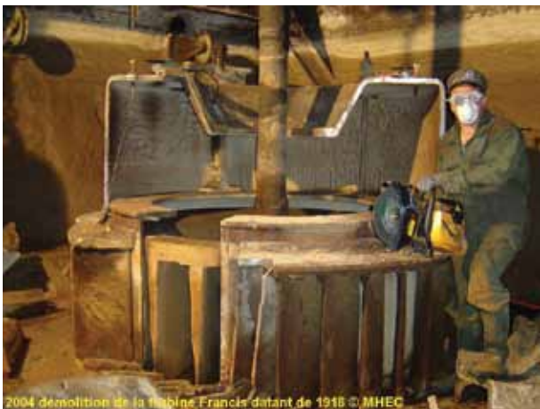
Démolition d'une turbine Francis.
